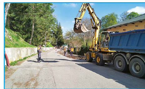
■ Zahájení prací v ulici U Stadionu, odtěžení staré konstrukce komunikace
