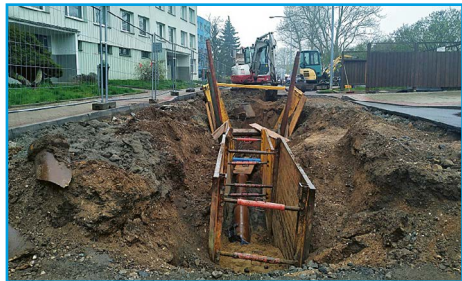
■ Pokračuje pokládka kanalizačního řadu
