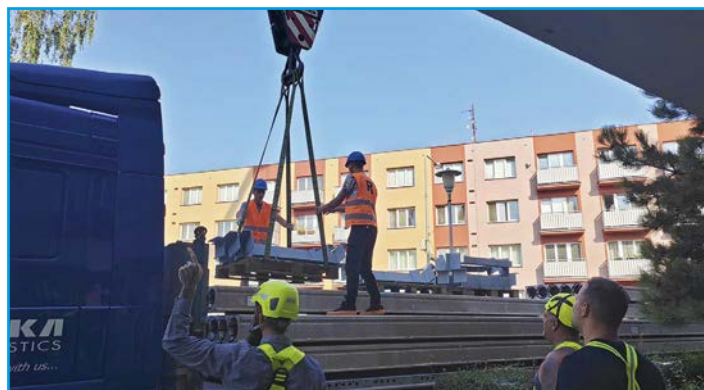
■ Pokládání stropních panelů
