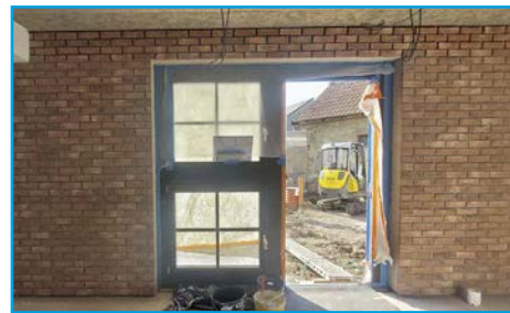
■ Pohled z interiéru
