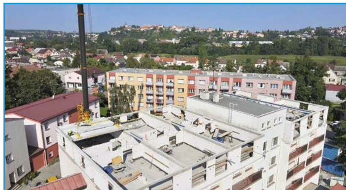
■ Pokládání stropních panelů
