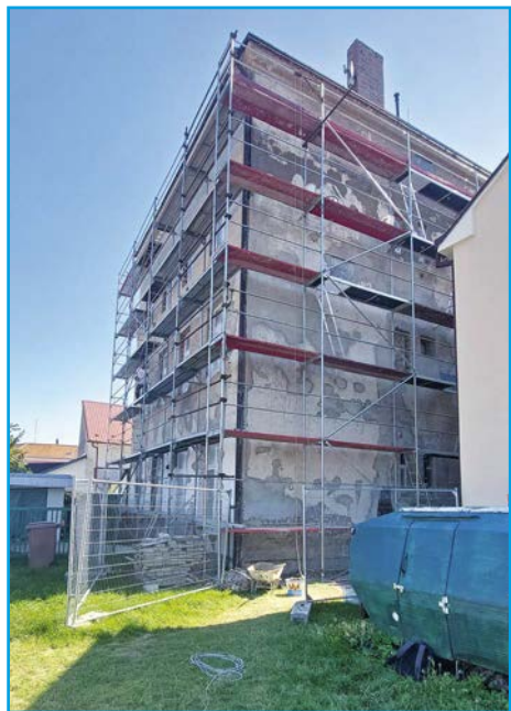
■ Zadní trakt domu při opravě fasády
