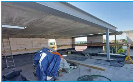
■ Probíhá montáž stropních panelů
