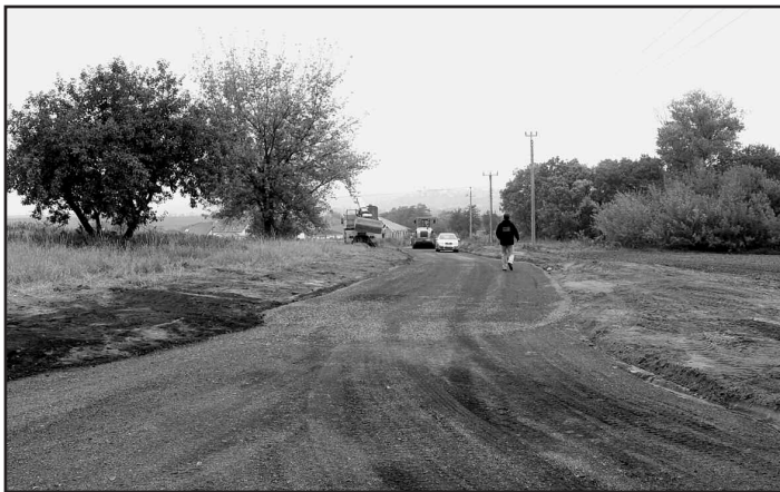
Stavební práce na výstavbě přístupové komunikace ke sportovní rekreačnímu areálu ve Kbele byly zahájeny ve druhém týdnu měsíce září
