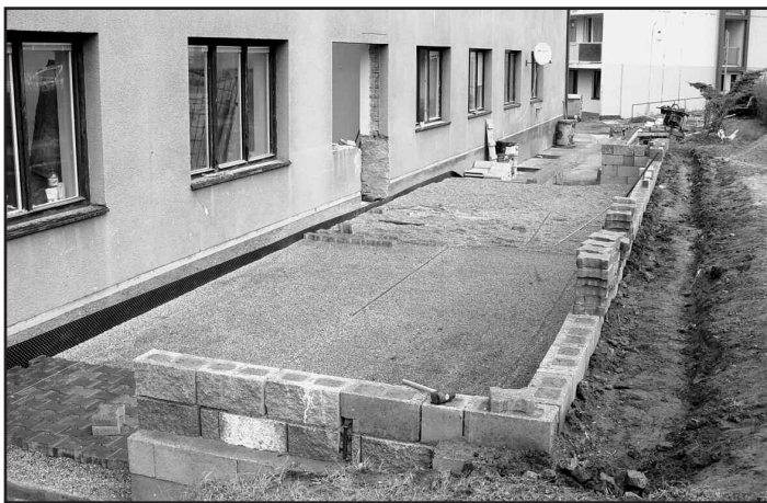
Snímek zachycuje pokládání zámkové dlažby na terase Klubovny seniorů v přízemí budovy Městské ubytovny
