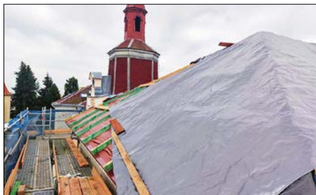
■ Výměna střešní krytiny na ZŠ Pražská
