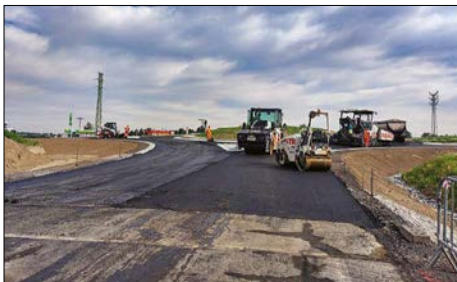
■ Pokládka asfaltového povrchu v kruhové křižovatce
