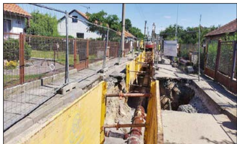
■ Pokládka kanalizačního řadu v ulici V Koreji
