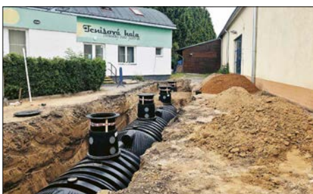
■ Nádrže v areálu zimního stadionu před zasypaním
