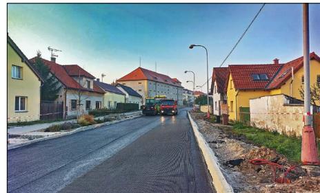
■ Ulice Pražská - pokládka asfaltového povrchu
