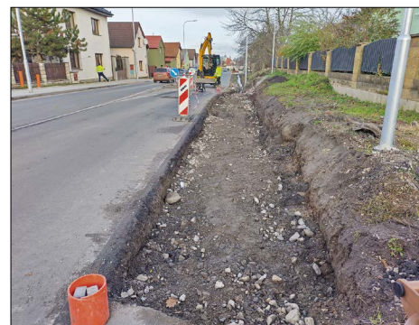
■ Zemní práce na novém chodníku
