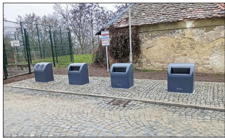
■ Dokončené podzemní kontejnery
