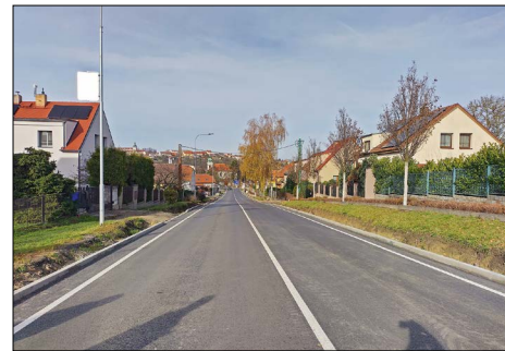
■ Nový asfaltový povrch v ulici Bratří Bendů
