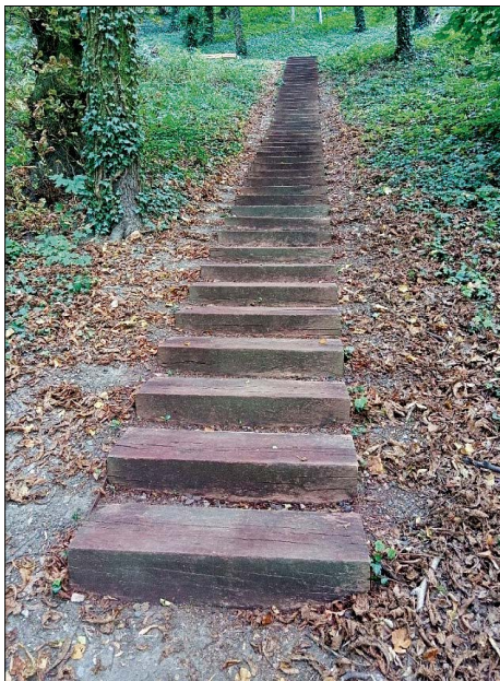
■ Dřevěné schodiště v Podzámeckém parku po ošetření
