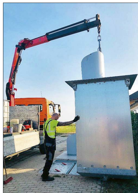
■ Čištění podzemních kontejnerů v ulici U Vodojemu
