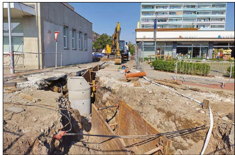
■ Oprava kanalizačního potrubí mezi ulicí Pražská a Ořeňov
