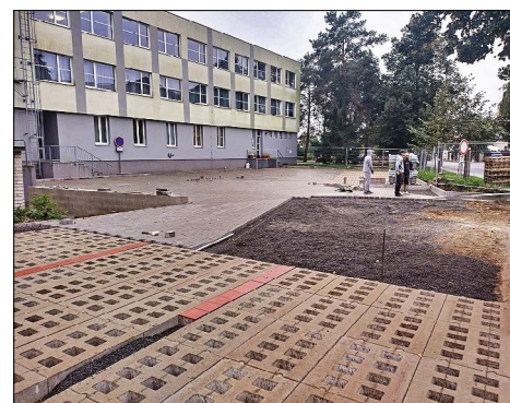
■ Odstavná plocha u hotelu Bílý páv – dokončuje se pokládka zámkové dlažby
