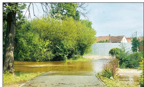
Protipovodňová ochrana v Dělnické ulici
