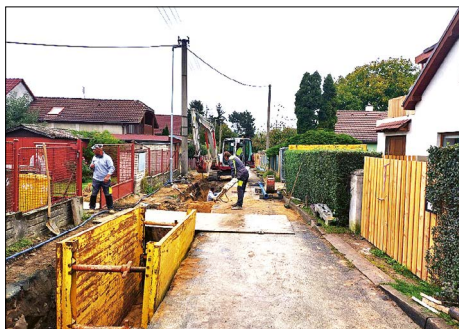
■ Úprava ulice V Koreji – pokládka vodovodního řadu
