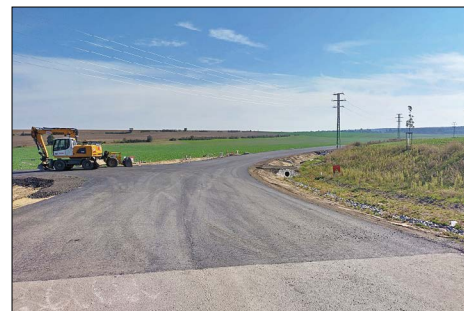
■ Stavba „II/272 Benátky nad Jizerou, připojení na sil. III/27212“ – dokončená pokládka první vrstvy asfaltu
