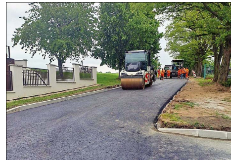
■ Pokládka asfaltového povrchu
