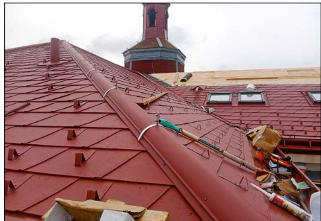
■ Pokládka nové střešní krytiny
