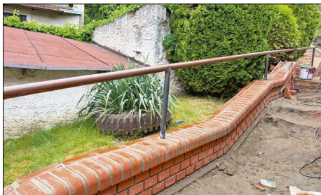
■ Opěrná zídka z plných cihel
