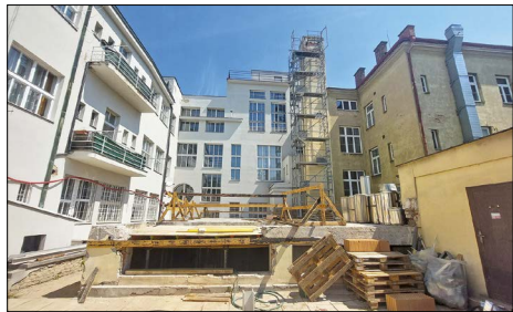
■ Bourací práce na objektu kotelny
