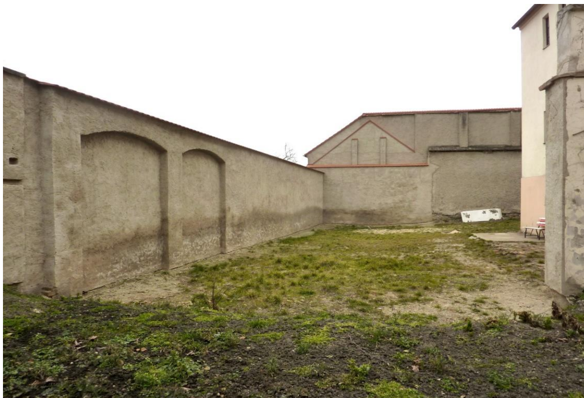
Dvůr Základní umělecké školy ve Smetanově ulici
